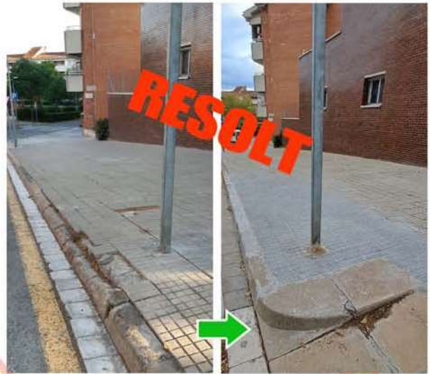
Cruïlla C/ Puig i Cadafalch amb Plaça Cal Gravat ( vorera dreta )
